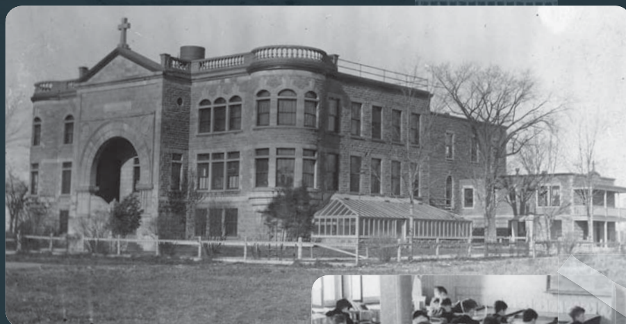
Les travaux sont achevés
